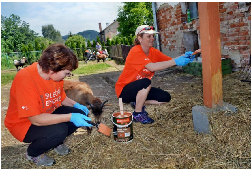
Nátěr kozího chlívku
